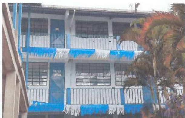
Foto1: Mantenimiento y Reparación de Barandas, Segundo y Tercer Nivel
