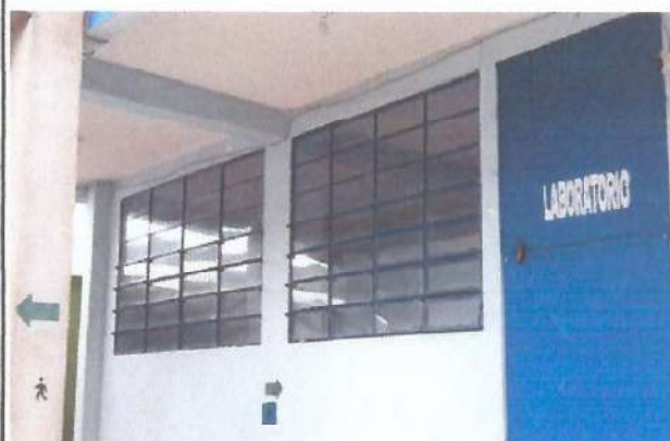
Foto 2: Reparación y Mantenimiento de Ventanas. (Laboratorio)
