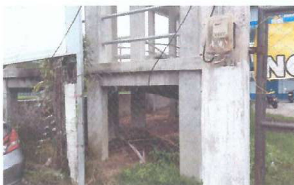
Foto 3: Mantenimiento de Muro Perimetral
